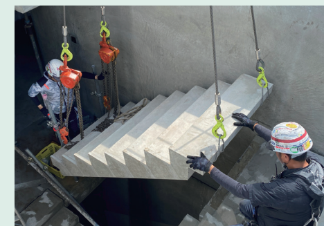
川越工場から輸送されたPC部材を広島県の建設現場で組立て
